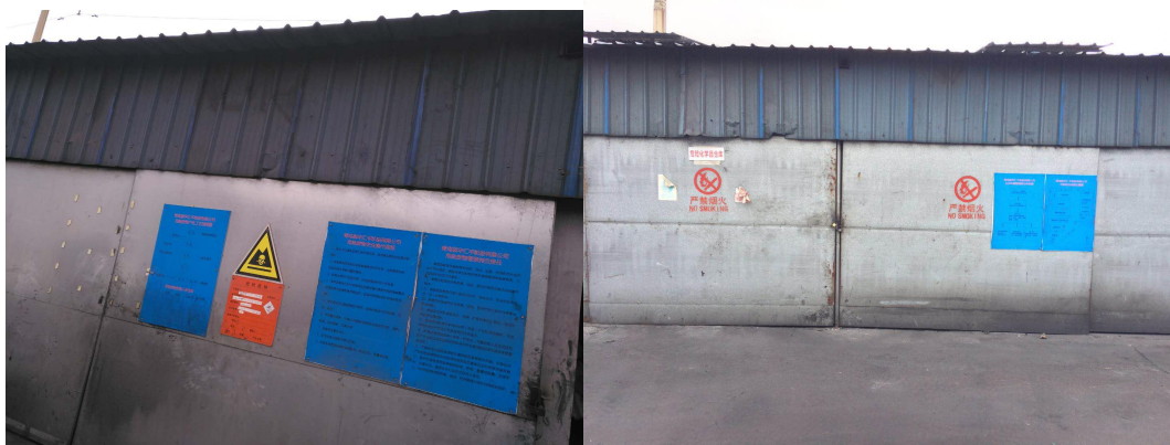
危险废物仓库
